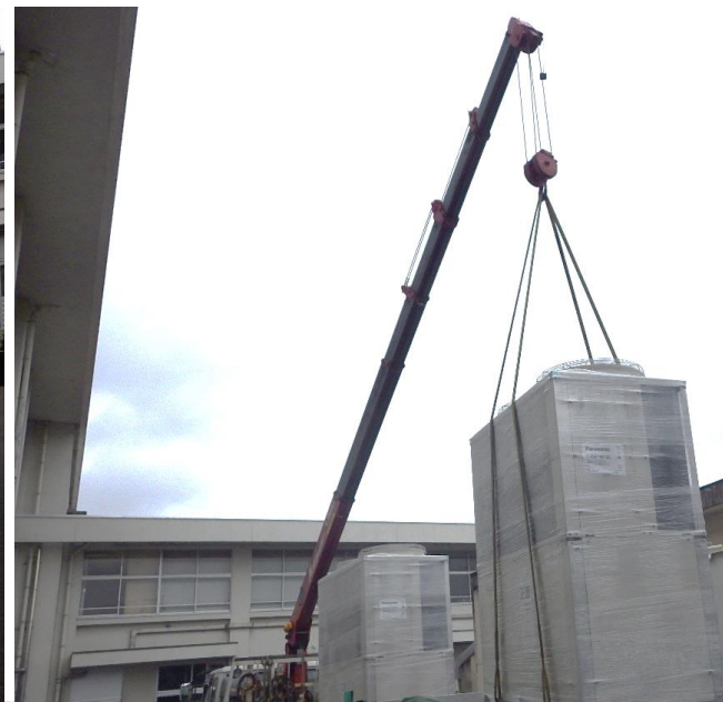
工事名 高岡市立福岡中学校 普通教室空調機設置工事 高所作業車 15m 配置
